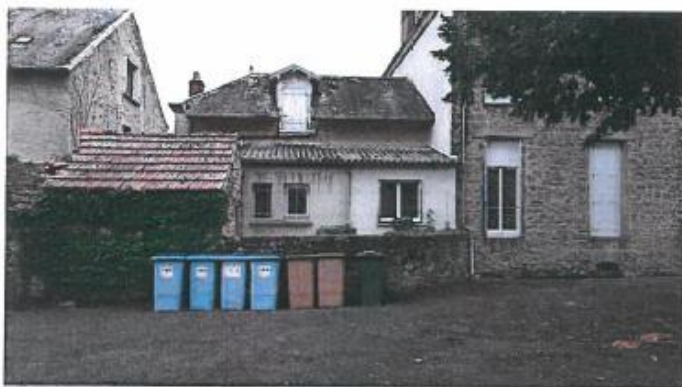
Façade existante mairie
