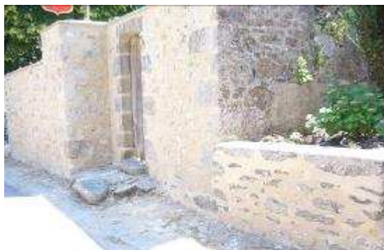
Le mur de l'annexe de l'auberge a été rénové
