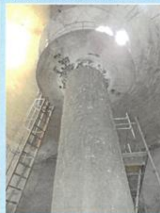
intérieur du réservoir avant réagréage et étanchéité
