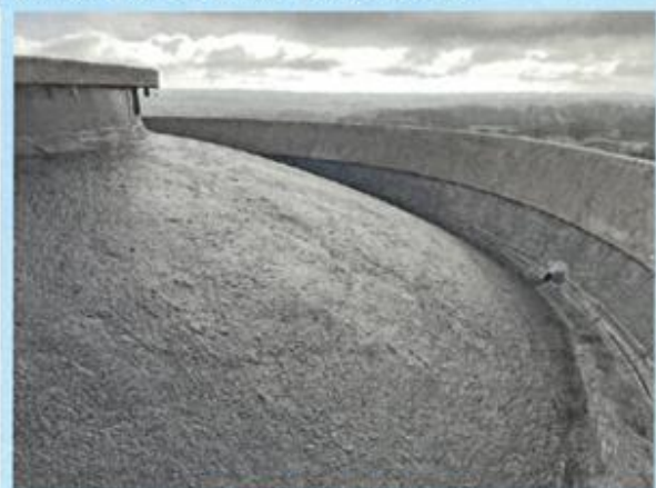
étanchéité du dôme
