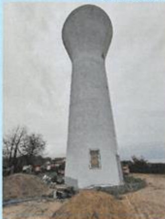
nouvelle couleur du château d'eau après décapage
