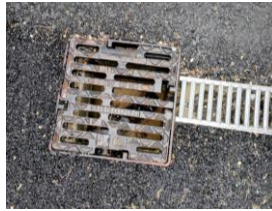
Des grilles sous lesquelles on voit l'eau couler
