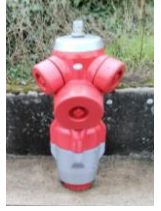
Des bouches à incendie
