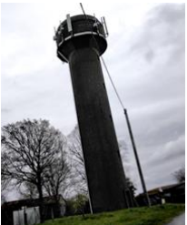
Le château d'eau
