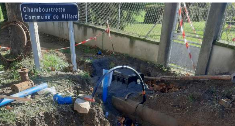
Le trou de canalisation
